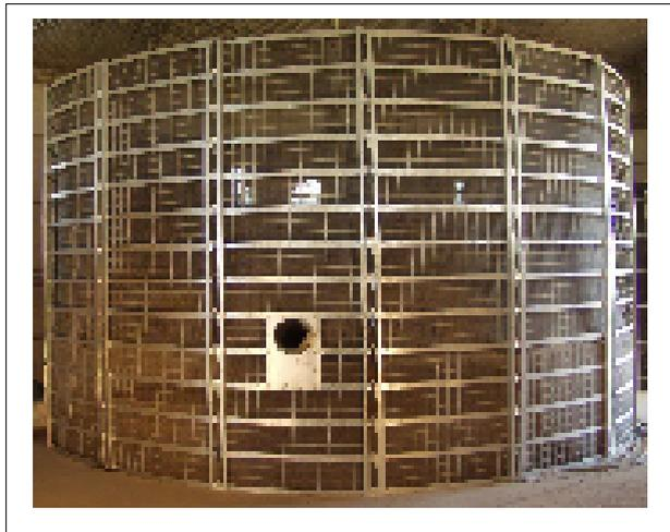
Siempre el silo debe estar armado sobre un piso donde no entre humedad de abajo. Cuando el grano es de mucho valor ó cuando sea almacenado por un tiempo prolongado siempre se aconseja poner un sistema de aireación en el silo.
